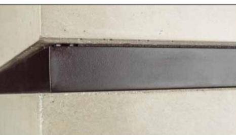
Die Zwischenlage sorgt für die Abdichtung der beiden Gehäuse, nachdem die Kabel gelegt sind
